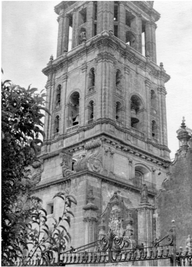
Torre oriental de catedral en su estado actual desde el lado norte, con el 2o. y 3er. cuerpos, además de la bóveda, en forma de campana. Estas últimas, son posteriores a la época de Pérez de Soto (Foto G. Bolis).
